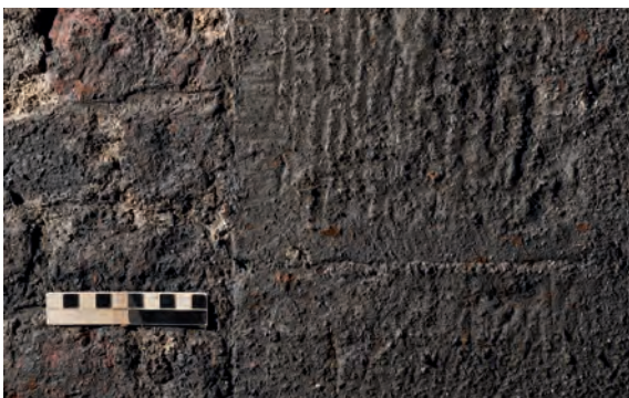
Abb. 19: Schachthalle: Sandstein mit ebenem Spiegel und Randschlag, dessen linke Seite bereits durch Ziegelmauerwerk verdeckt ist (Foto: Deutsches Bergbau-Museum Bochum/P. Thomas).
