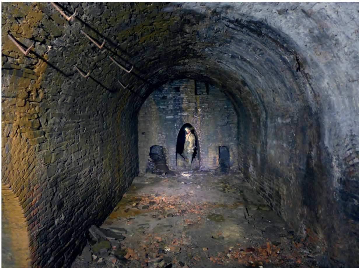
Abb. 14: Blick von der Dampfmaschinenplattform in die Kesselhalle. Am linken Bildrand öffnet sich die Kesselhalle (Zugang nur im Ansatz erkennbar) zur parallel vorbeiführenden Strecke. Die beiden schwarz gefärbten Maueröffnungen in der Stirnwand dienten als Rauchgasabzüge der zwei ehemals vorhandenen Dampfkessel (Foto: R. Golze).
