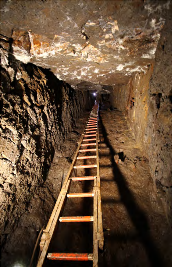
Abb. 7: Ausgemauerte Fahrung (Abb. 2-3: F) in der Nachbarschaft des Hauptfördergesenks (Foto: LWL-Archäologie für Westfalen/M. Zeiler).
