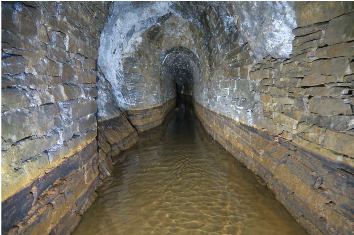
Abb. 6: Tiefer Stollen Landeskrone in einem ausgemauerten Stollenbereich. Distanz zwischen Wasserspiegel und Firste ca. 1,8 m (Verein für Siegerländer Bergbau e.V./T. Radenbach).
