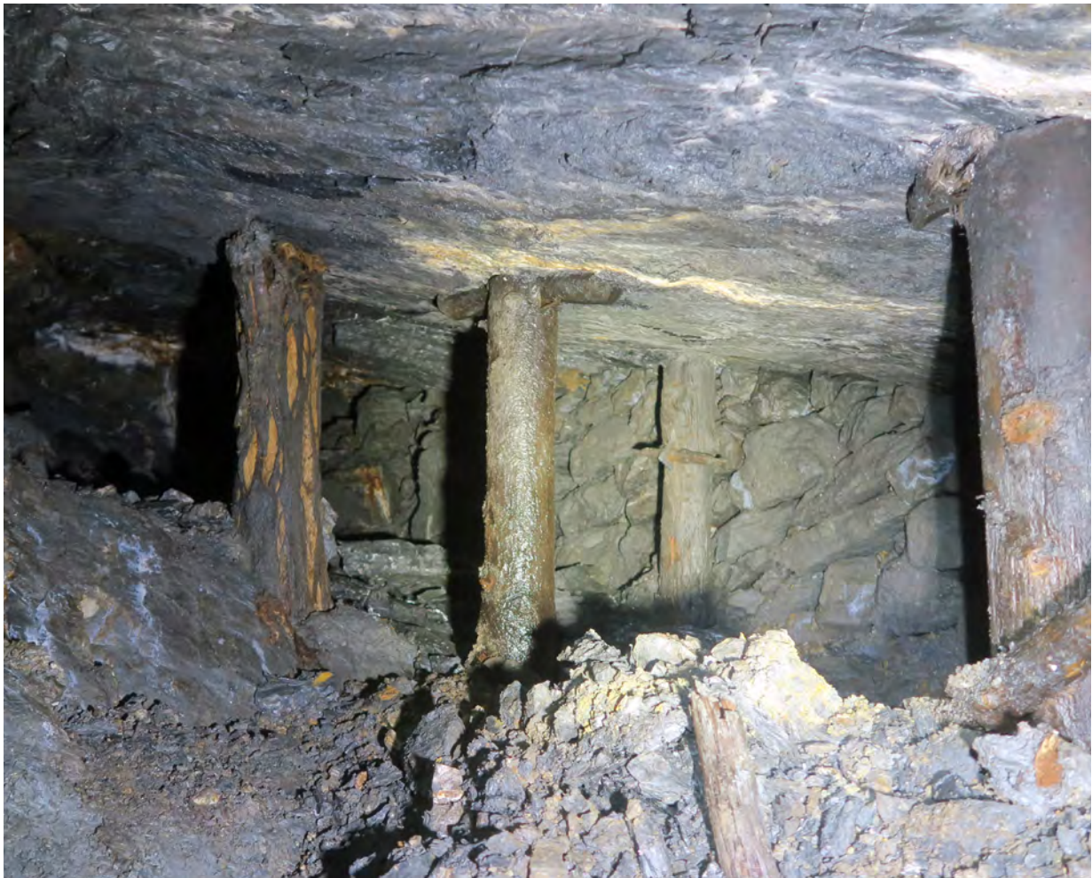
Abb. 11: Ausgeerzte Gangspalte im oberen Bereich des 1. Südlichen Mittels. Schön sind die Holzstempel und die Versatzmauer zu sehen, welche die Firste stabilisieren (Foto: Verein für Siegerländer Bergbau e.V./A. Kossek).
