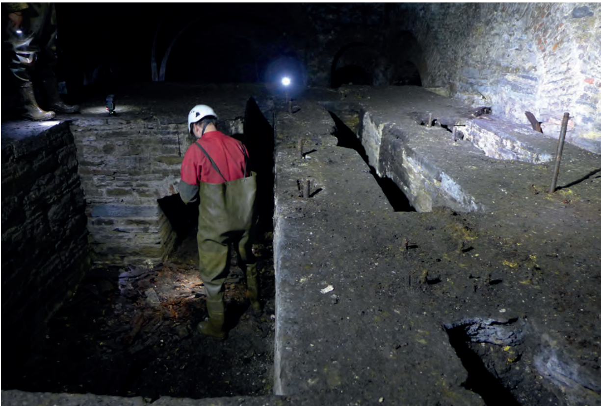
Abb. 16: Dampfmaschinenplattform (Blickrichtung Schachthalle). Am linken Bildrand befindet sich die Aussparung der Seiltrommeln, rechts die des Schwungrades der Dampfmaschine, z. T. mit herausragenden eisernen Fundamentschrauben (Foto: R. Golze).
